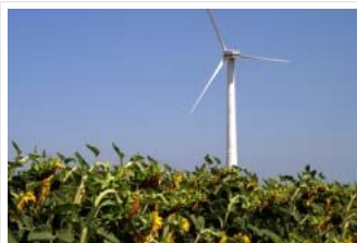
"Еолика" възобновява строителството на ветроенергийния парк край Суворово
